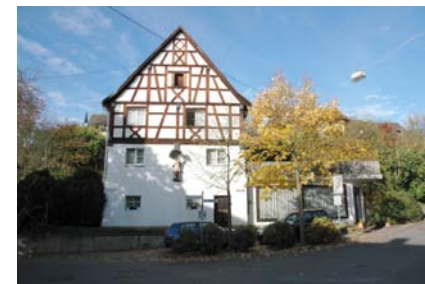
Ostfassade gegen die Kreuzung
