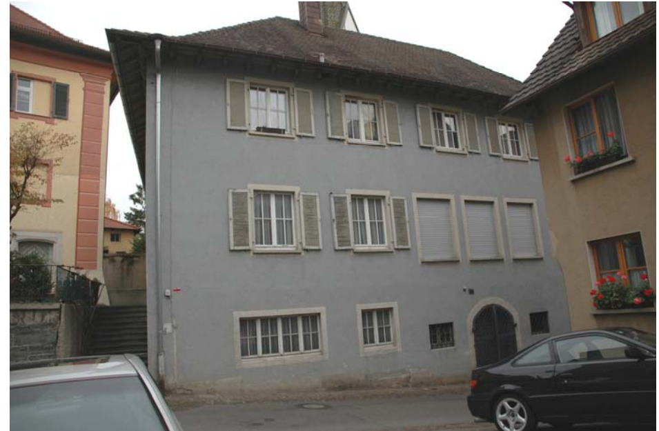
Westfassade gegen die Rathausstraße mit Kellerbogen
