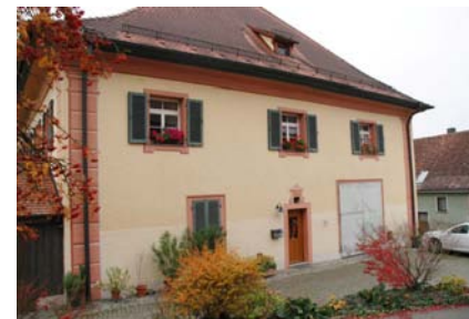
Blick auf die Nordfassade
