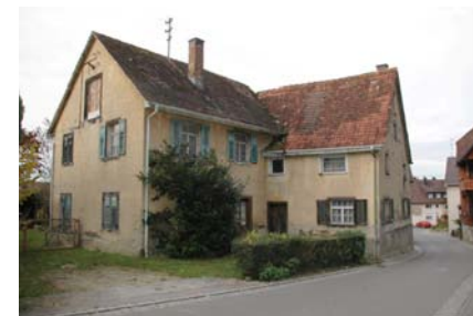
Ansicht von Osten mit jüngeren Anbau
