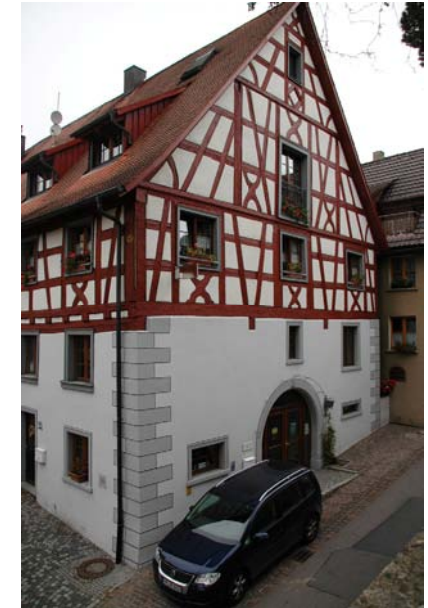
Blick auf den Ostgiebel, vom ehemaligen Kirchhof aus
