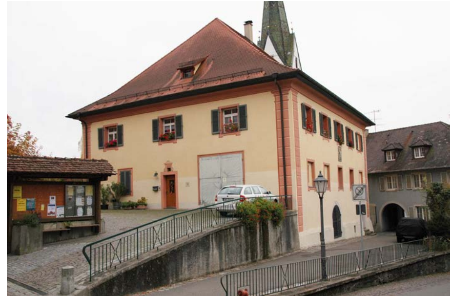
Schrägansicht von Nordwesten (im Hintergrund der Turm der Pfarrkirche)
