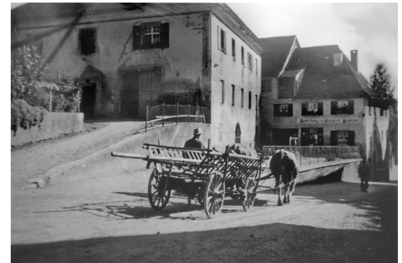
Die Rathausstraße auf Höhe Mainauer Amtshaus, um 1950 (Quelle: Lohrer)
