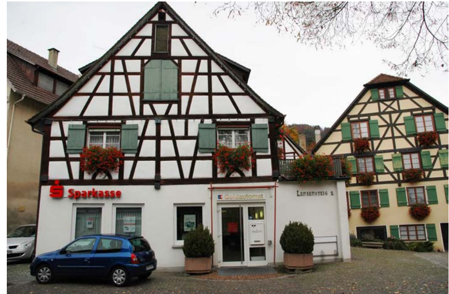
Ansicht gegen den Lenzensteig
