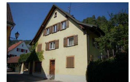
Ansicht von Südosten (Foto: Ref. 26)
