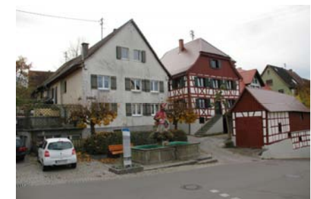
Blick von NW, rechts Auf dem Boll 1
