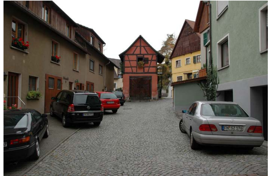
Blick von der Rathausstraße in Richtung W, auf das Nebengebäude Nr. 2
