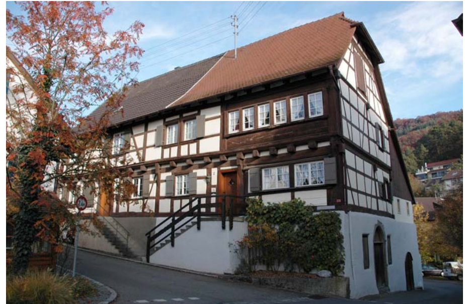
Ansicht von der Klosterstraße aus in Richtung NW
