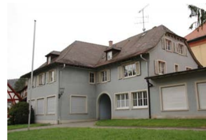
Südfassade gegen den Kirchhof
