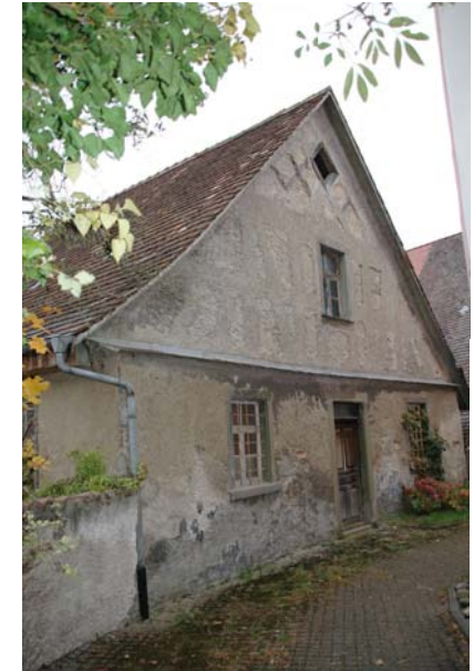
Ehem. Kaplanei, Nordgiebel
