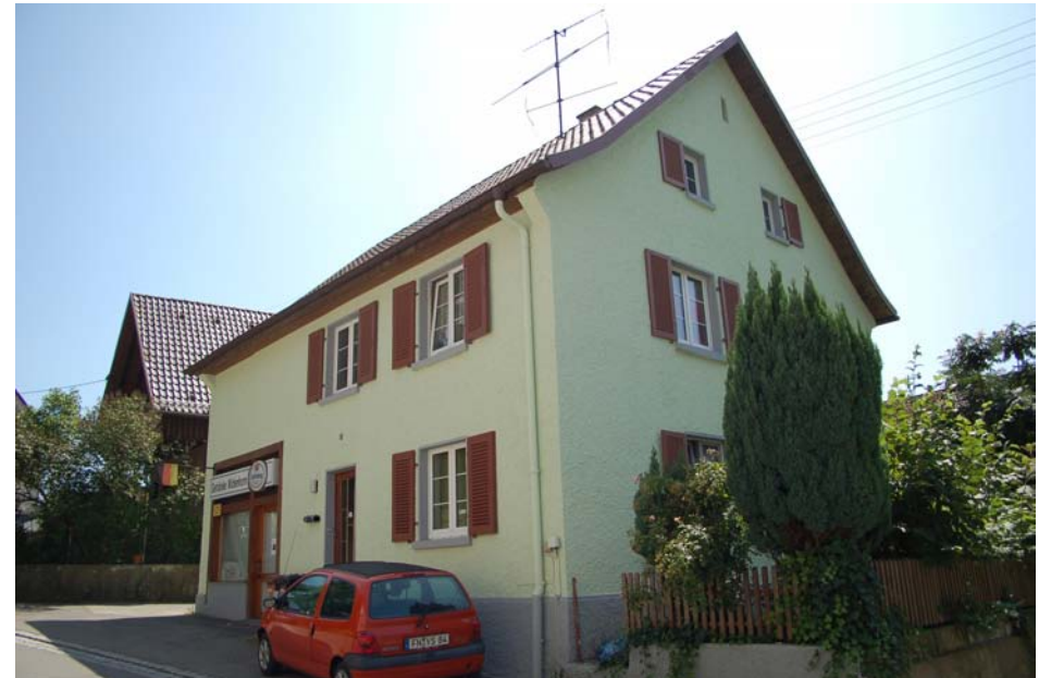
Ansicht von Nordwesten (Ref. 26)
