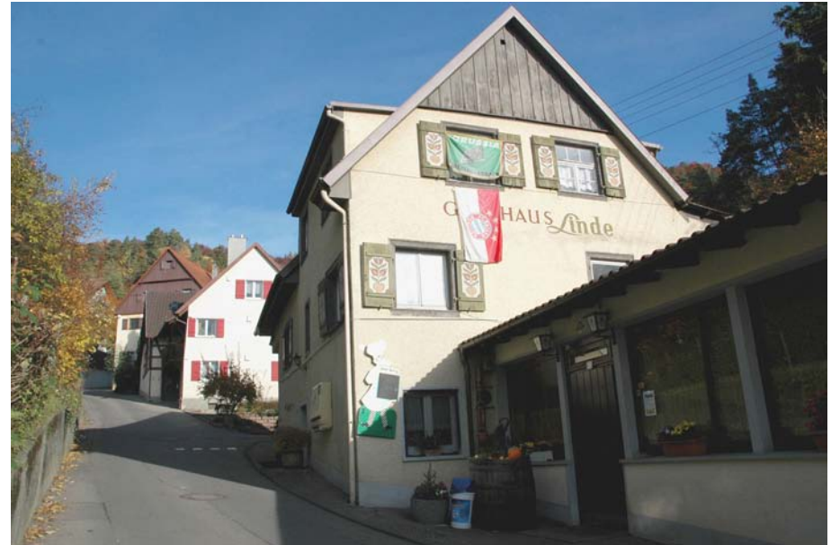
Blick in Richtung Norden, Höhe Nr. 2
