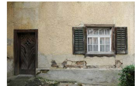
Fassadendetail Altbau (Ostfassade)
