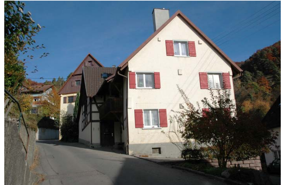
Ansicht von Süden, am Abzweig gegen die Lochmühle
