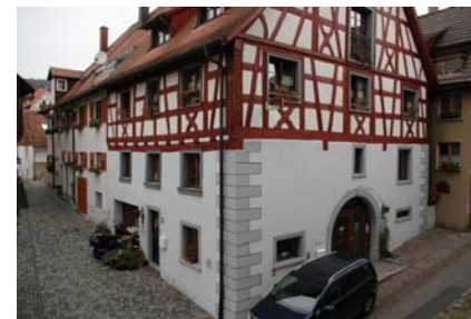
Ansicht von NO
