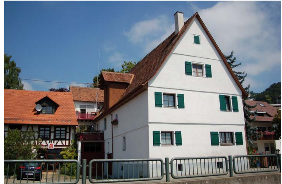
Ansicht von Südwest mit erhaltenswerter Aufzugsgaube (Ref. 26)
