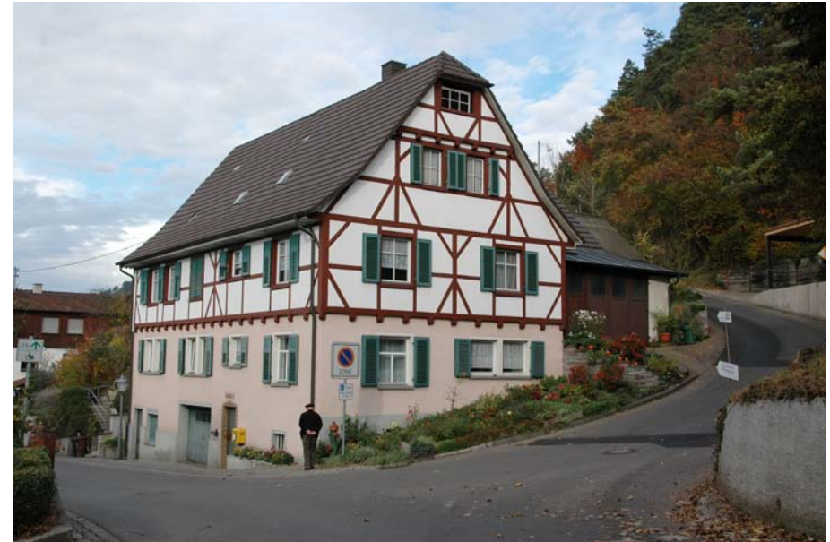
Ansicht von Südosten am Abzweig zur Kleinen Steige
