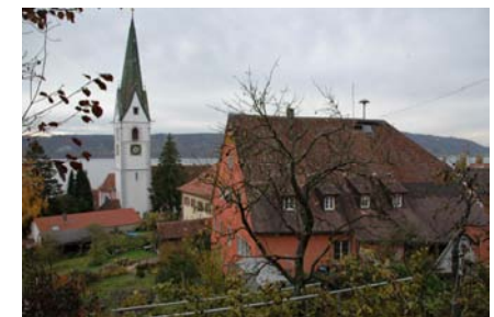
Blick auf die Rückfassade
