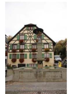
Gesamtansicht mit Brunnentrog
